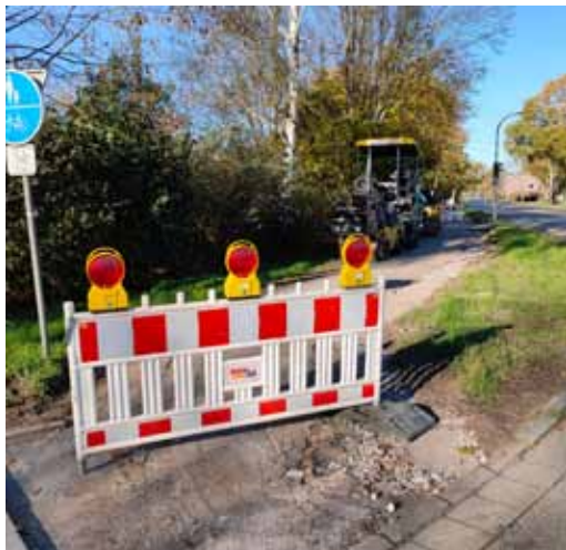
Mitte November – Bauarbeiten an der Straelener Str.
